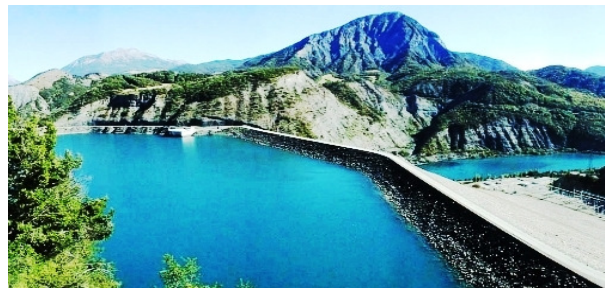
Figure 2 : Barrage de Serre-Ponçon, dans les Hautes-Alpes.
