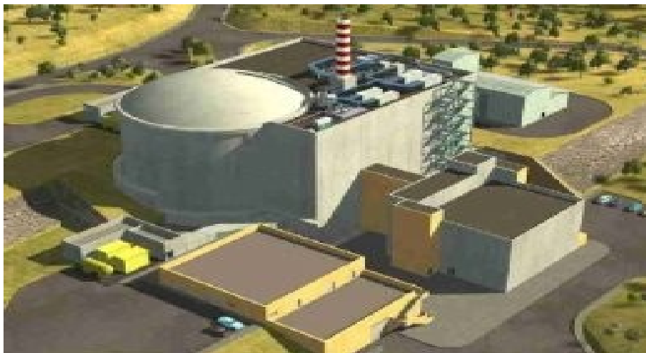
Des sin du Réacteur Jules Horowitz (RJV), actuellement en cours de construction à Cadarache. Ce réacteur de recherche permettra de tester des matériaux et la production de radioéléments artificiels (REA) indispensables à la médecine moderne.
